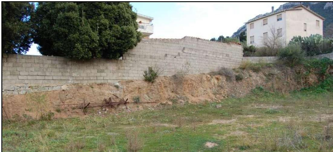
Fotografia 1. Sezione di scavo interna al centro abitato di Oliena (Via Su Linu) impostata su granitoide in facies leggermente alterata. Alla base della scarpata si osserva a luoghi roccia granitoide in facies francamente litoide.
