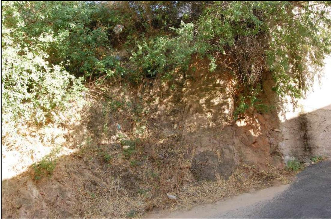
Fotografia 3. Sezione di scavo interna al centro abitato di Oliena (Via Su Linu) impostata su granitoide in facies leggermente alterata.
