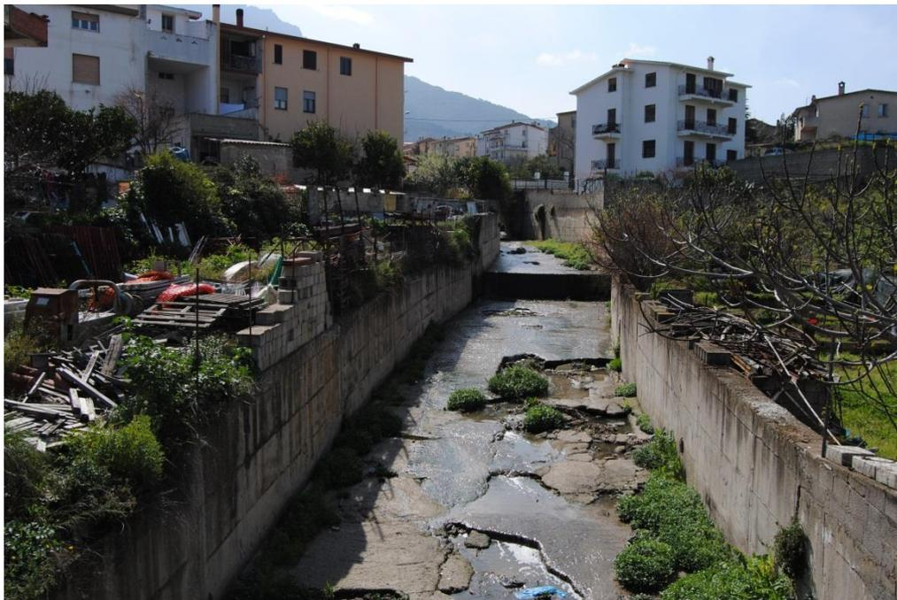
Figura 32 – Erosione fondo Rio Caschio tratto a monte dell'attraversamento\_133
