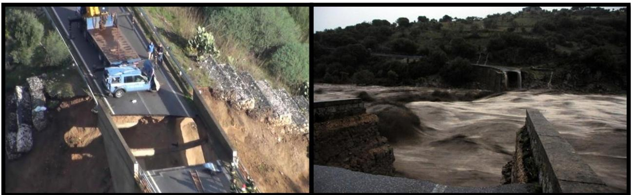
Figura 21 - Immagini dei crolli sul ponte di *Oloè* e sul ponte di *Norgheri* a seguito del *Ciclone Cleopatra*
